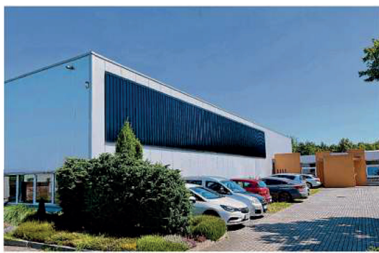
Diese Kollektorfassaden werden inzwischen deutschlandweit montiert. Foto: Maik Sommer/Etopart AG
